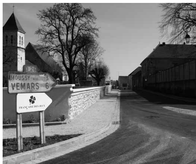
Les travaux de réhabilitation de la rue de Paris à Moussy-le-Vieux se sont achevés le 20 mars 2009.
