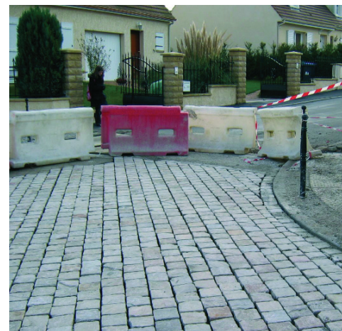
Travaux de voirie à Moussy-le-Vieux
